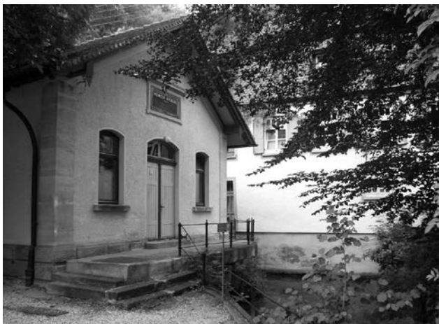
Pumpstation am Lautertopf 2004 Bild: Gemeindearchiv
