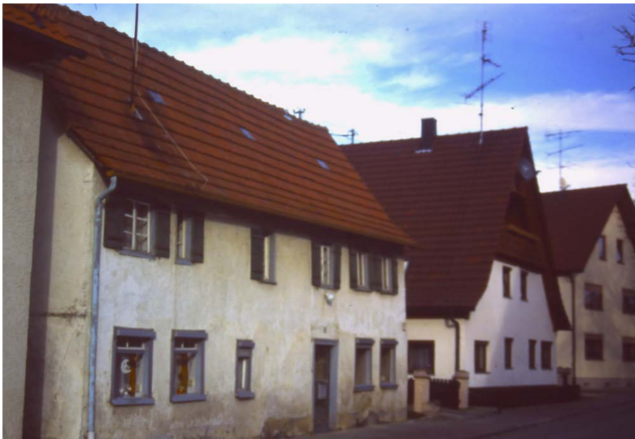
Gebäude Bäckerei Seyfert - Abriss 2012 Bild: Hansjörg Honold
