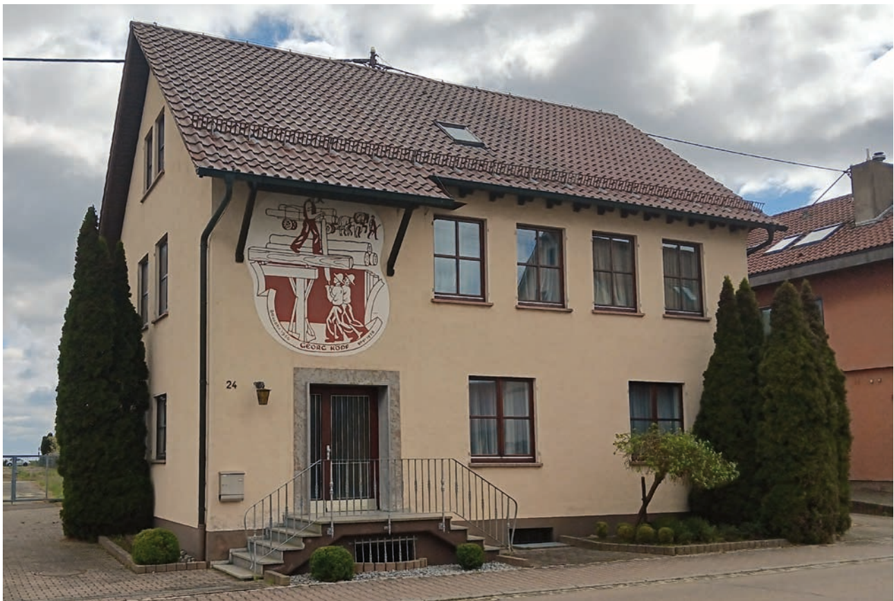
Bürogebäude in der Temmenhauser Straße 22 Bild: Hansjörg Honold
