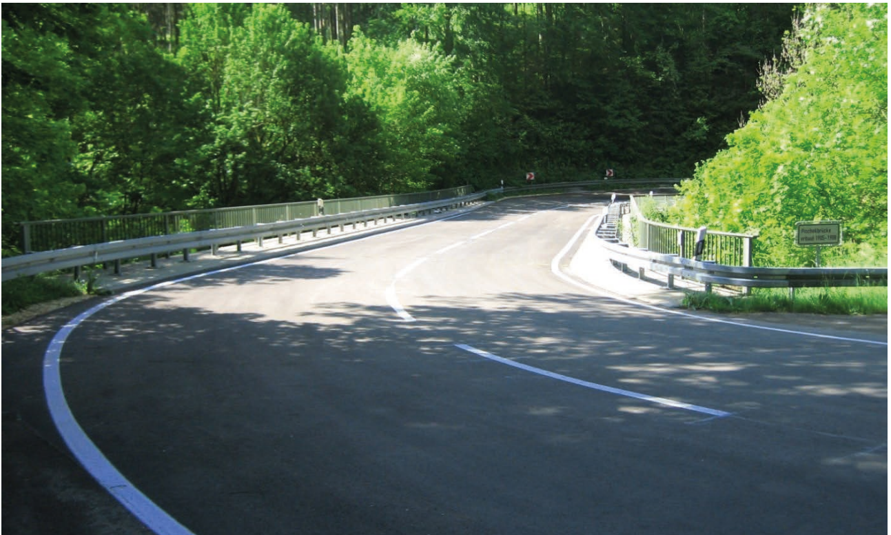
Die heutige Überfahrt über die sanierte Brücke (Bild Juni 2019) Bild: Hans Mutschler
