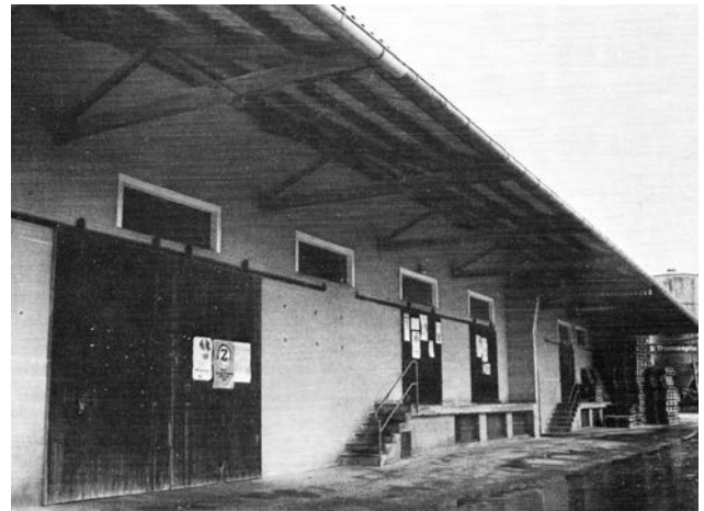
Lagerhaus Bermaringen im Friedhofsweg Bild: Hans Mutschler
