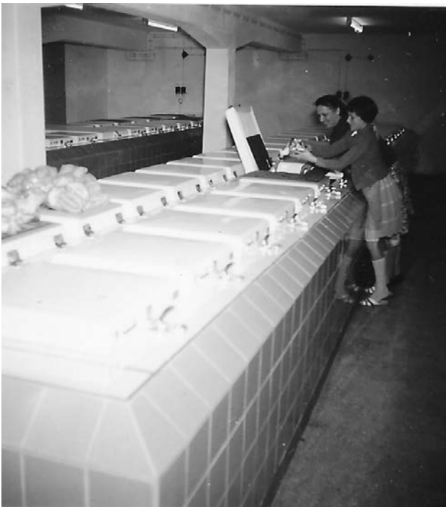
Gemeinschaftsgefrieranlage im Lagerhauskeller Bild: Anna Danner
