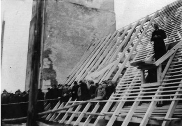
Das Richtfest und der Richtspruch Bild: Hans Mutschler
