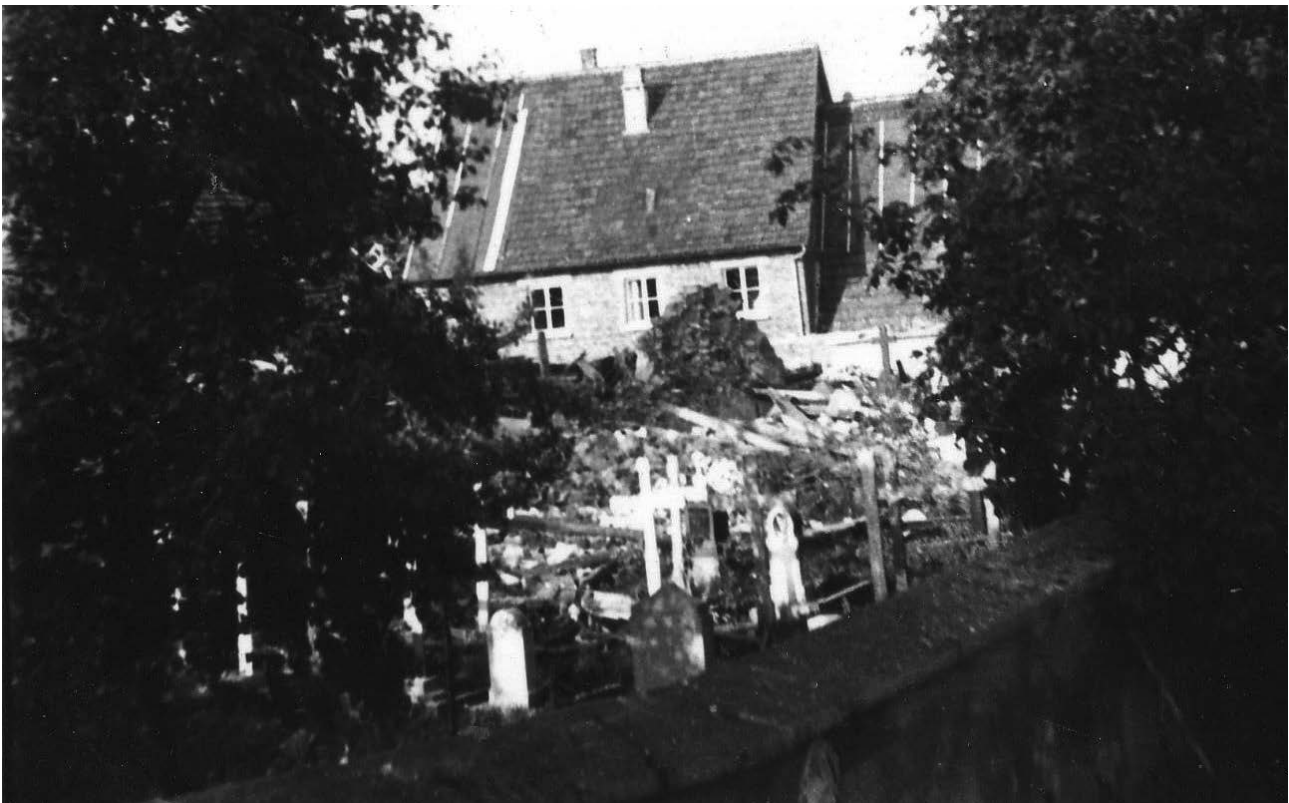
Der verschüttete Friedhof auf der Nordseite und beschädigte Häuser Bild: Hans Mutschler
