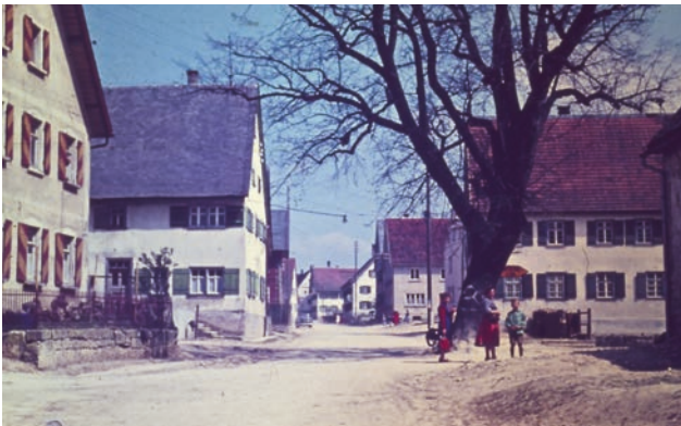
Blick in die Lange Straße, heute Dorfstraße vor dem Kanalisieren
